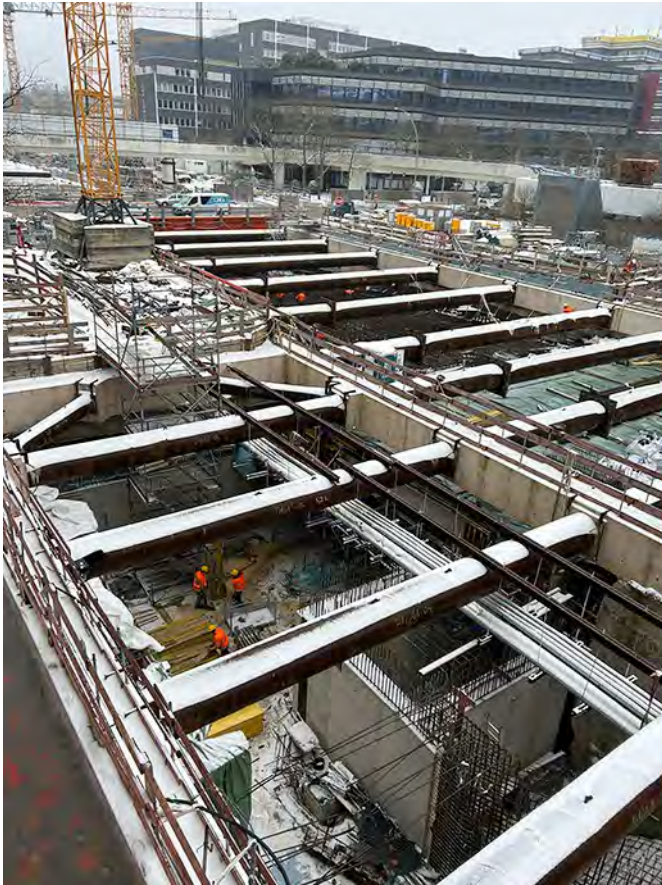
Die Baustelle der U5 in der City Nord am 17. Februar (Fotos: Heike Sudmann)
