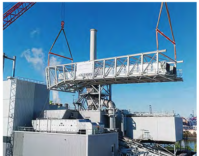
Puzzle auf der Großbaustelle: Zwei Kräne heben das letzte Anlagenteil in die Großbaustelle ein (Foto: Perspektive Media /Hamburg Wasser)
