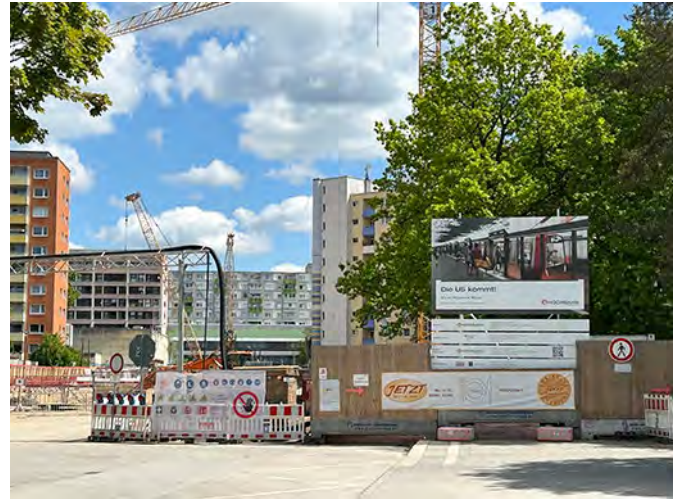
Die U5-Baustelle in Steilshoop am 15. Mai
